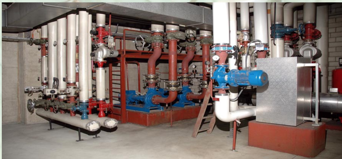
Hier trifft 85 Grad warmes Wasser vom Fernheizwerk der Stadt Zürich ein (unten links). In der rechten Bildhälfte die Anlage zur Rückgewinnung von Abwärme, die wieder ins Wärmenetz eingespielen wird.
